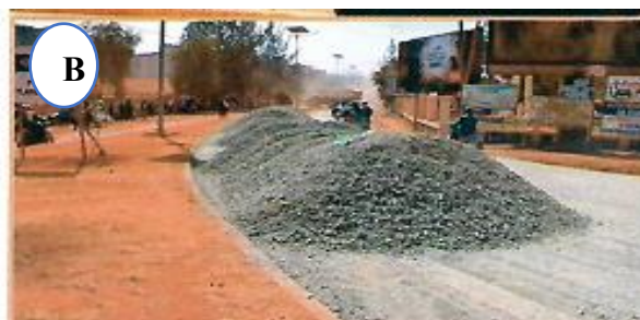
Voirie urbaine de la Ville de Dschang en Chantier
